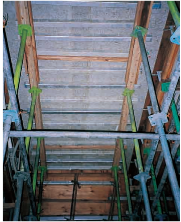
型枠用木毛セメント板を使用した例
